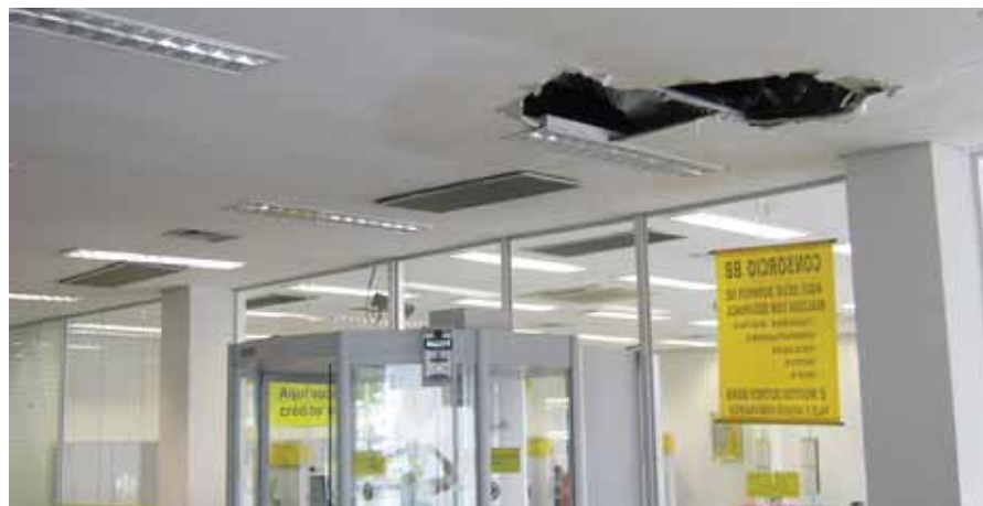
Forro cede na agência Nova Indaiá
